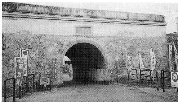
左営旧城遺址の城門
