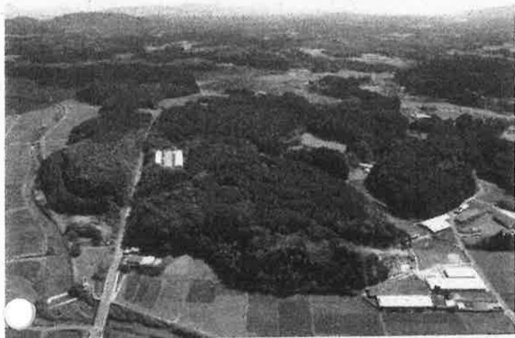
写真1 平松城跡航空写真(北側から撮影)
