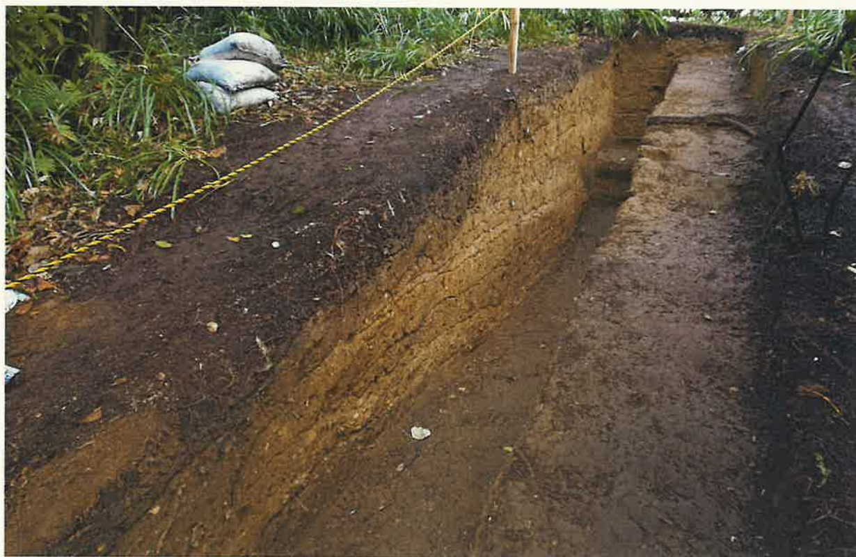
写真5 2トレンチ土壘盛土状況（南西より）
