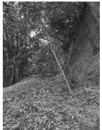
写真④ 曲輪1下の切岸と通路
